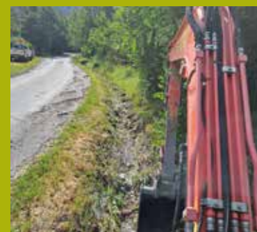
Curage fossé après orages à Beauvoir.
